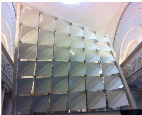
Abb. 4: 6x6m großer Demonstrator der Flectofold Fassadenverschattung auf der TRR 141 Ausstellung im SMSN © PBG & SMSN
